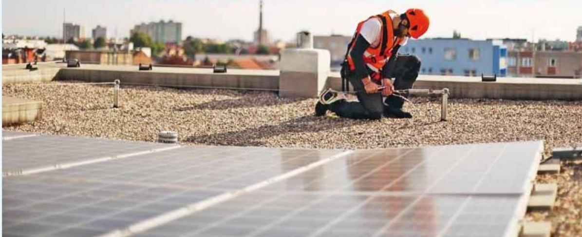
Pro bezpečnou instalaci a údržbu solárních panelů se vyplatí záchytný systém na střeše. Rooffix
